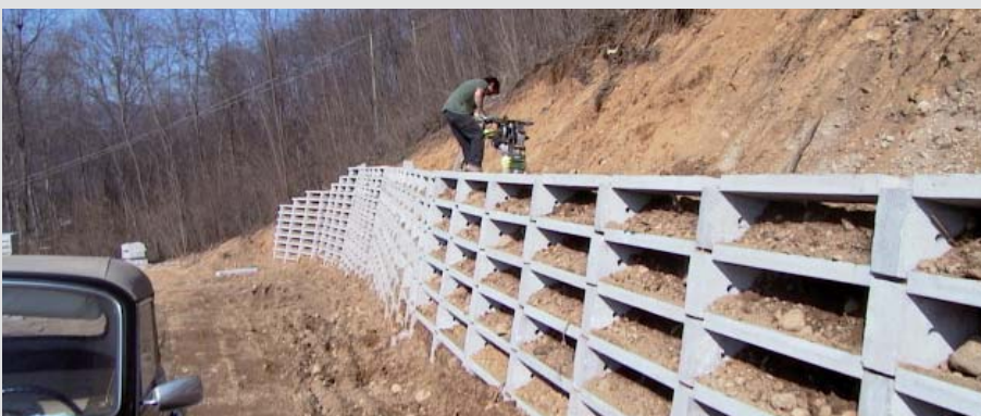
Il terreno viene costipato ogni 2 strati con piccoli motocompattatori.
